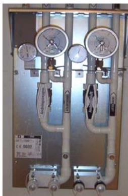
Tryckövervakare för andningsoxygen och andningsluft.
