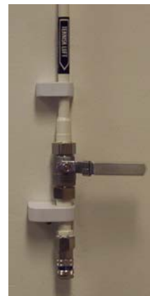
Uttag teknisk luft CEJN typ 320 Avstängningsventil skall ej vara låsbar.
