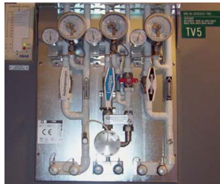
Tryckvakt för andningsoxygen, lustgas och andningsluft med slavregulator.
