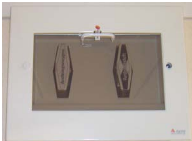
Nödvästängningslåda för andnings- oxygen och andningsluft
